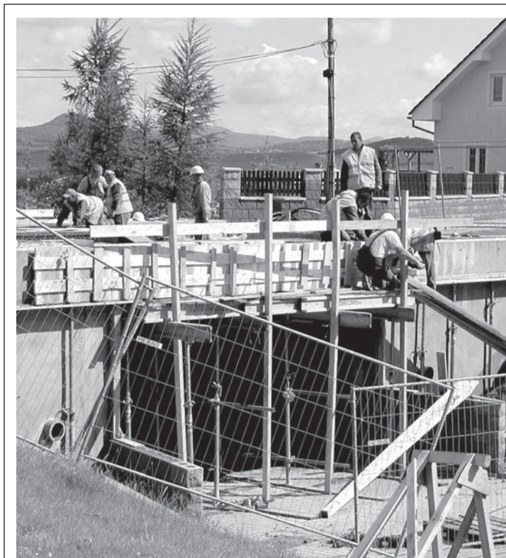
▲ Minulostí by se měla tento týden stát rekonstrukce podchodu v ulici V Domcích v Lounech. Investiční akcí „Generální oprava podchodu v ul. V Domcích“ měla na starost firma N+N konstrukce a dopravní stavby, s. r. o., Litoměřice. Odstranila při ní nevyhovující nosné konstrukce mostu včetně celého vozovkového souvrství a nově zhotovila nosné konstrukce z monolitického železobetonu včetně mostního svršku. Zachovány byly jen krajní opěry, ale i ty byly zpevněny. (foto tu)
