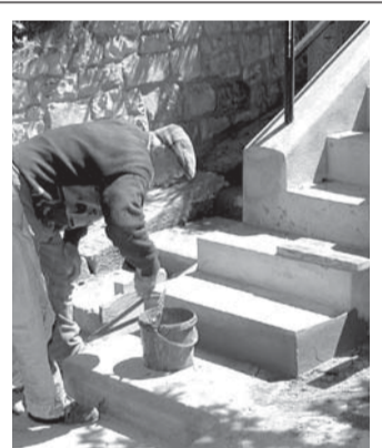
▲ V současné době probíhá oprava schodiště u historického vodočtu na břehu Ohře v místech, kudy prochází pěší stezka podél řeky. Schody jsou jednou z možností, jak se na tuto procházkovou trasu napojit. Kamenická firma Zdeňka Buka dostane za rekonstrukci 49.504 Kč i s daní. (foto tu)
