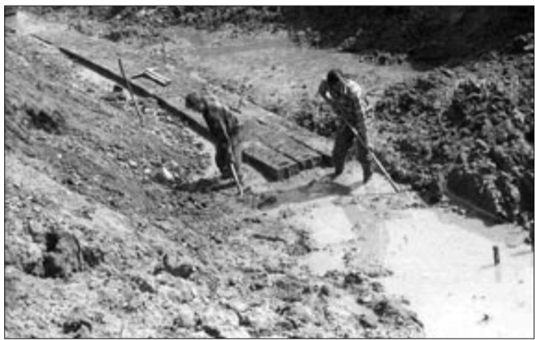
Práce u melioraci byla často mimořádně náročná.
